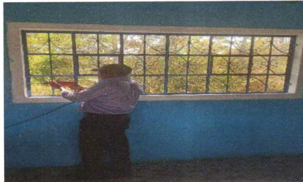
Foto 2: Instalación de ventana de metal
