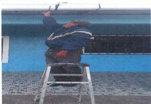
Foto 3: Colocación de canal plástico
