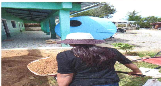
Foto 7: Trabajando para colocar la cisterna de plástico
