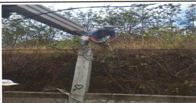
Foto 5: Reparación de muro perimetral
