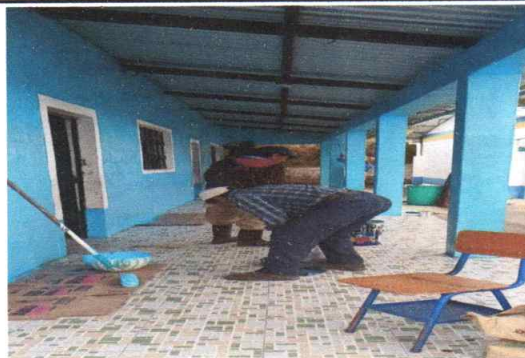
Foto 4: Aplicación de pintura en paredes
