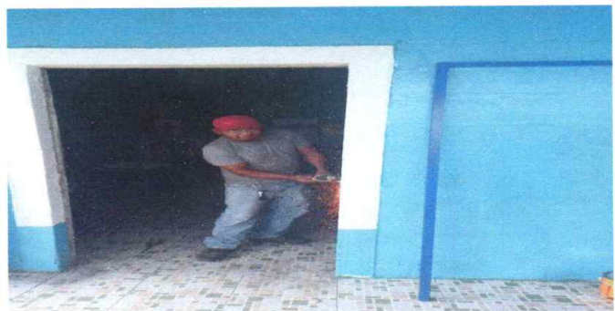
Foto1: Instalación de puerta de metal
