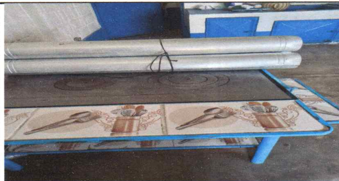
Foto 8: Colocación de estufa mejorada
